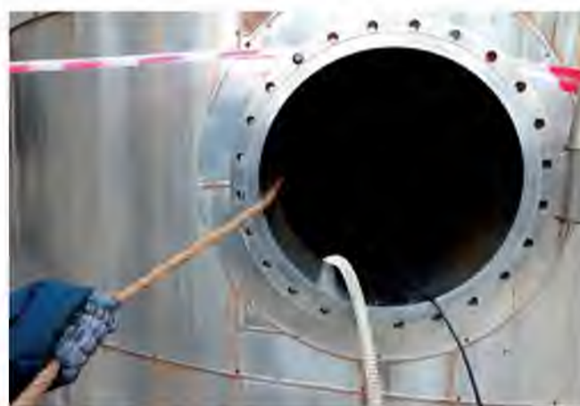
Шаг восьмой. При отсутствии зрительной и радиосвязи между работающим и наблюдающим должна быть установлена система подачи условных сигналов при помощи верёвки
