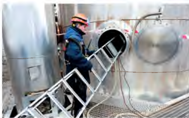
Шаг пятый. Специалисты замечают, что погружаться в аппарат следует в таком порядке: сначала помещают в ёмкость ноги, затем корпус и только после этого – голову. Так у газоанализатора, который находится у вас на поясе, больше времени, чтобы в случае опасности предупредить вас!
