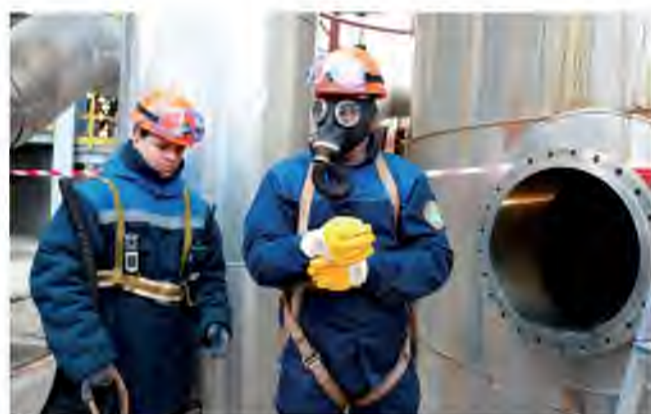
Шаг третий. Проверьте наличие средств индивидуальной защиты. Используйте предохранительный пояс и страховочную привязь с сигнально-спасательной верёвкой. Помните: нельзя использовать фильтрующие противогазы!
