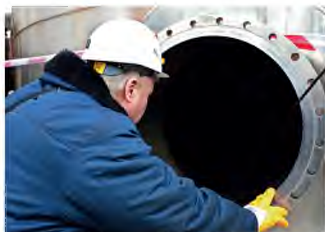
Шаг десятый. После окончания работ убедитесь в том, что внутри ёмкости нет работников, ведущих ремонт, а также инструментов и посторонних предметов
