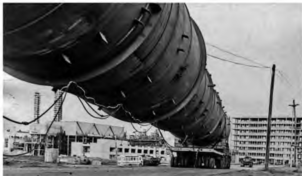
Продолжается строительство завода. На площадку Тольяттиазота поступает крупногабаритное оборудование
