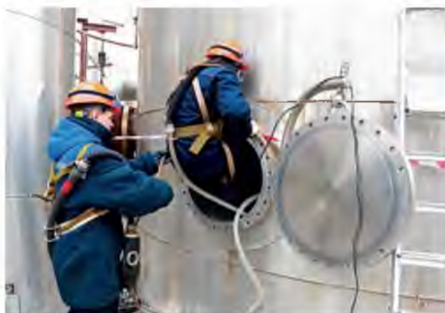
Шаг пятый. Специалисты замечают, что погружаться в аппарат следует в таком порядке: сначала помещают в ёмкость ноги, затем корпус и только после этого – голову. Так у газоанализатора, который находится у вас на поясе, больше времени, чтобы в случае опасности предупредить вас!
