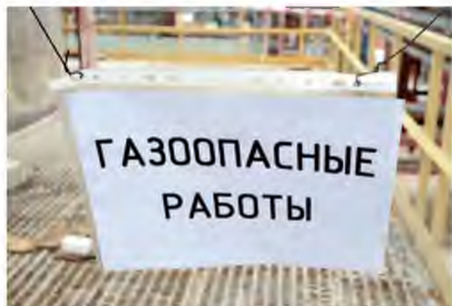
Шаг первый. Отключите аппараты, подлежащие вскрытию, от действующего оборудования и трубопроводов. Освободите ёмкость от опасных веществ. Территорию работ обозначьте!
